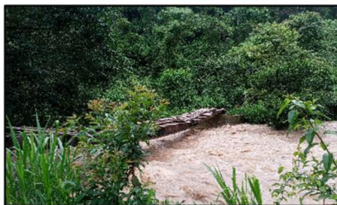
FIGURA N°03: A LA CRECIENTE DEL RIO SE GENERA LA SOCAVACION DE LAS PAREDES DE TALLUD DE LA RIBERA, GENERANDO EN TRAMOS EL DESPLOME DEL SUELO DE LA RIBERA.
